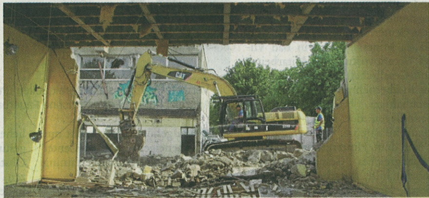
Im August 2015 rollten die Bagger am Bad Vilbeler Schulzentrum, die alte Turnhalle wurde abgerissen. Archivfoto: Christine Fauerbach
